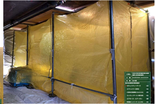
セキュリティブースの設置
