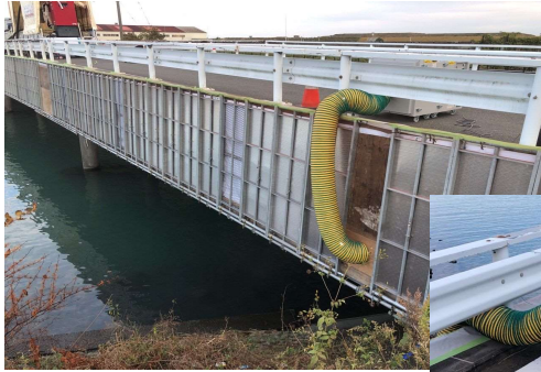
PCB含有物除去・処理状況
