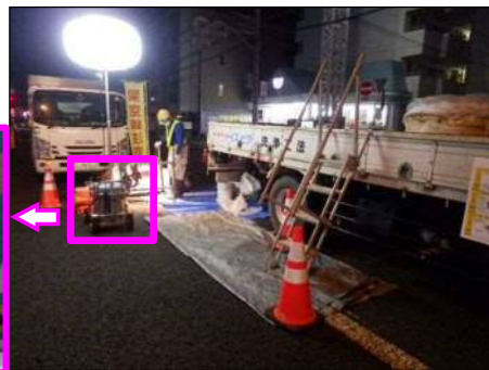
リチウムバッテリー電源式照明(使用時CO2ゼロ)
