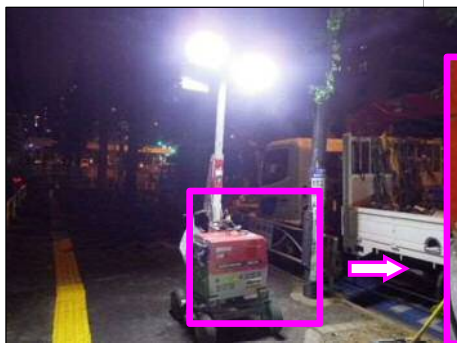
リチウムバッテリー電源式照明(東京支店)
